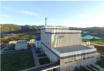
昆明三峰环保发电厂（1000吨/天）
