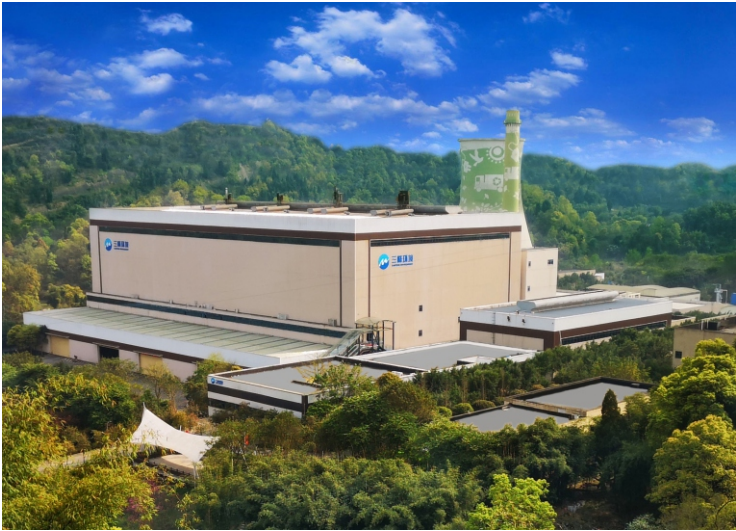
重庆丰盛环保发电厂（2400吨/天）
