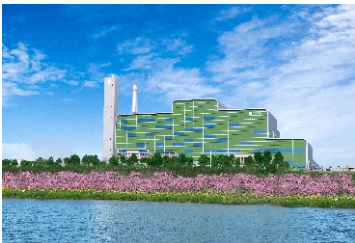
安徽六安环保发电厂（1200吨/天）
