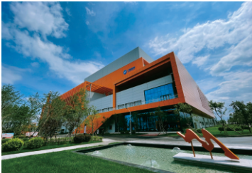
辽宁鞍山环保发电厂（1500吨/天）
